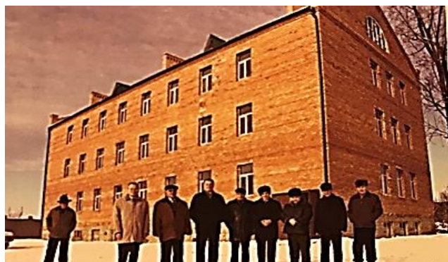
2006 г. Здание Чеченского республиканского центра ГМС
